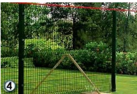
Мы уже возвели первую секцию и забетонировали столбы. Следующую панель крепим к предыдущему столбу для забора. Производится навеска панелей ограждения на столбы с помощью фиксаторов и метиза, которые входят в комплект ограждения.
