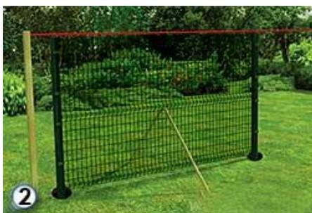
Для установки первой секции панельного ограждения и столбов положите 2 столба и панельную секцию ограждения на землю, соберите их, прикрепив столбы к секции с помощью соединительных клипс, но не фиксируйте их распорными болтами. Собранный секционную панель со столбами установите в предварительно обозначенные места, укрепляя собранную панель подпорами.
